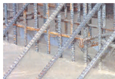
浄水場の「止水板」設置現場
